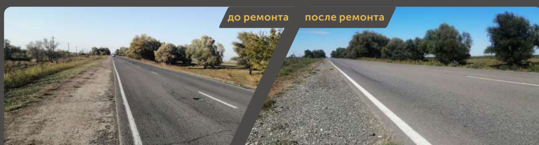
Астраханская область, автомобильная дорога Астрахань – Образцово – Травино
